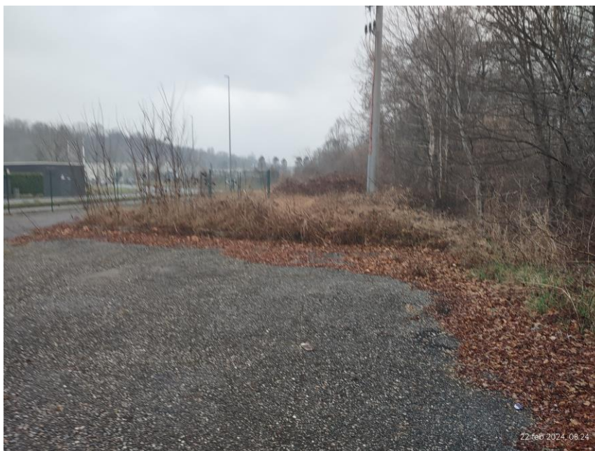
Figura 29 – Fotografia stato di fatto – lato ovest
